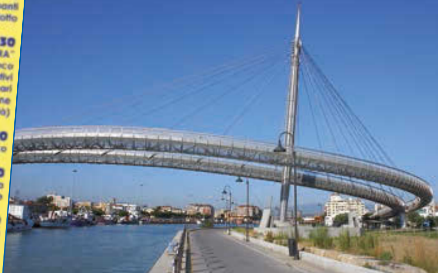
Il Ponte sul mare, uno dei simboli della città.
